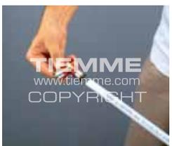
Inserire il tubo nel raccordo finché non arriva in battuta (verificare attraverso la "finestra" della ghiera)
