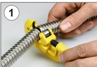
Отрезать трубу необходимой длины при помощи соответствующего трубореза (арт. 1683) (1).
