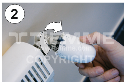
Установить регулировочную рукоятку в требуемое положение для ограничения диапазона рабочей температуры. Set the block system in the desired position to limit the working temperature range
