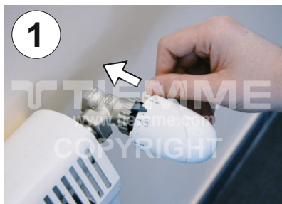
Вытянуть фиксатор книзу. Remove the block system
