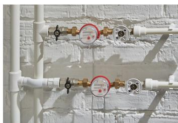
Sulle tubature di acqua fredda e calda vengono montate le valvole a sfera.
