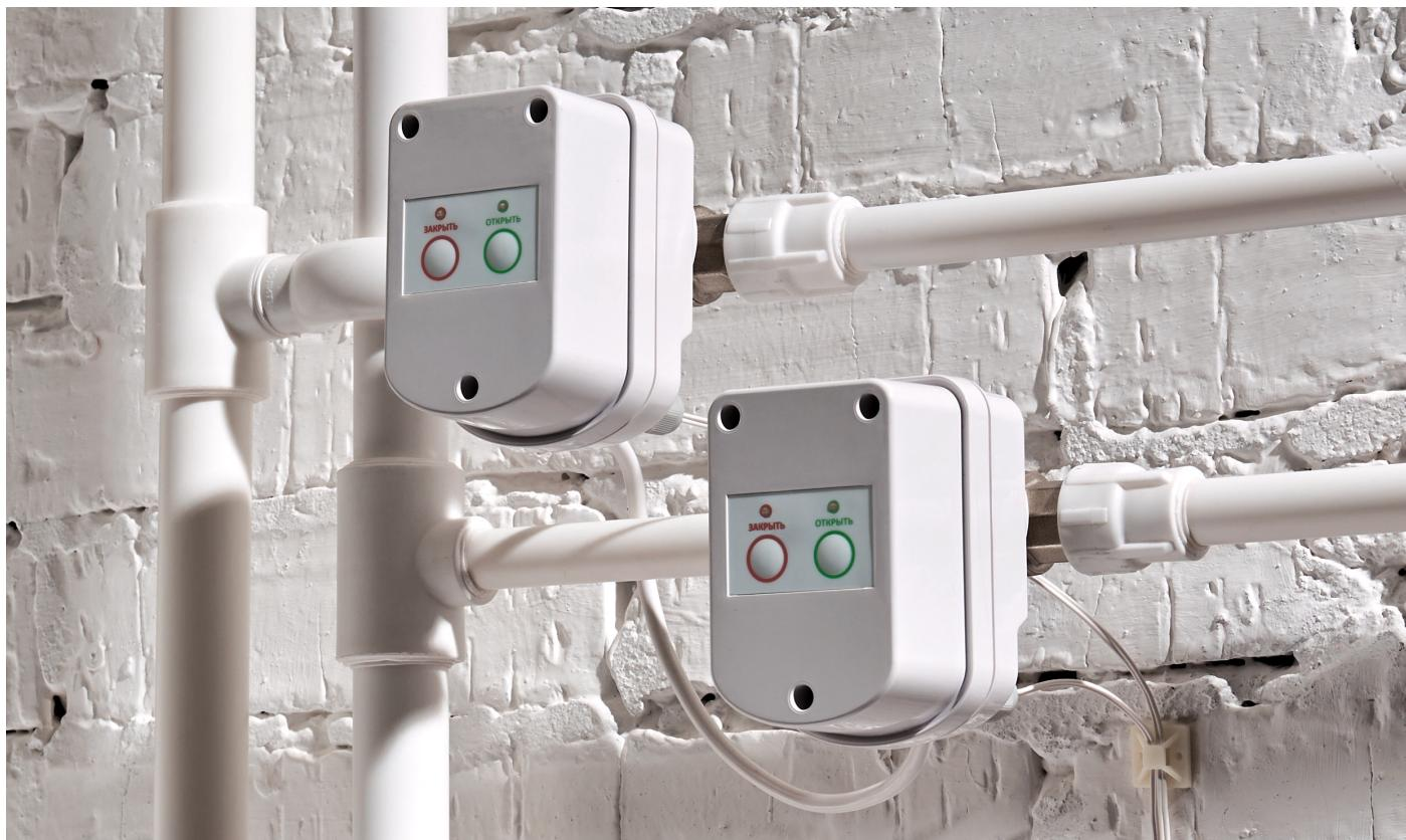
In caso di penetrazione dell'acqua nel sensore 1 collegato alla valvola a sfera motorizzata GIDROLOCK WINNER 2, sarà attivato un allarme acustico e sarà inviato un segnale di controllo per interrompere la fornitura d'acqua, che non riprenderà nemmeno in caso di interruzione dell'alimentazione.
