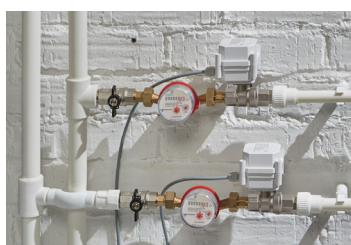
Fissare l'attuatore alla valvola a sfera mediante due dadi M5.
