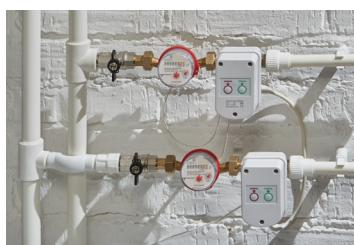
Passare il cavo di alimentazione da 12 volt ed i cavi dei sensori di perdita attraverso gli ingressi della valvola motorizzata GIDROLOCK TIEMME WINNER.
