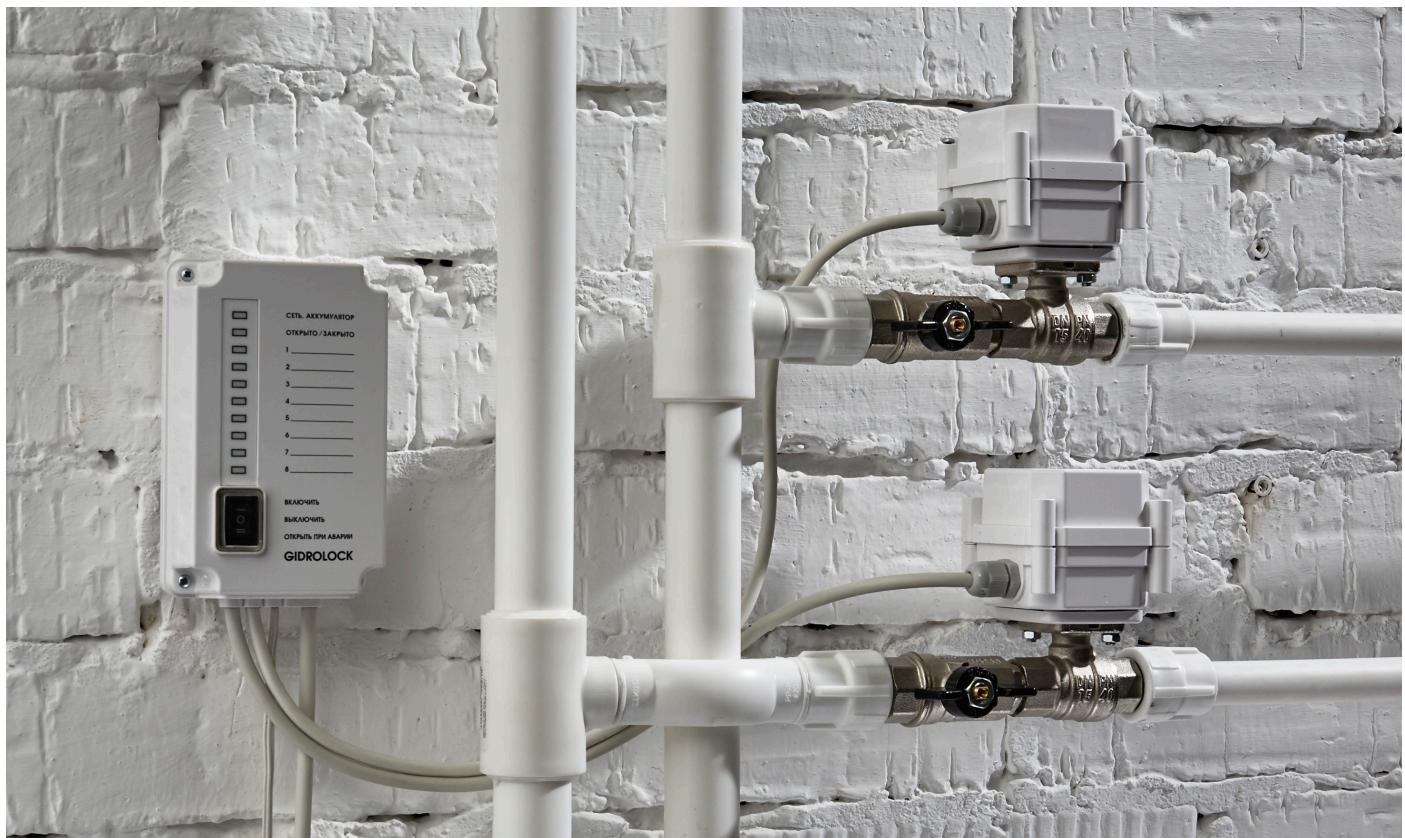
In caso di penetrazione dell'acqua nel sensore **1**, collegato all'unità di controllo **2**, sarà attivato un allarme acustico e sarà inviato un segnale di controllo alle valvole a sfera motorizzate **3** per bloccare la fornitura dell'acqua che non riprenderà nemmeno in caso di interruzione dell'alimentazione.
