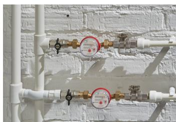
Sulle tubature di acqua fredda e calda vengono installati le valvole a sfera. È possibile montare le valvole sui tubi insieme agli attuatori.
