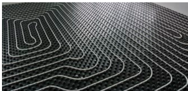
Рисунок 9: Укладка труб для теплого пола
